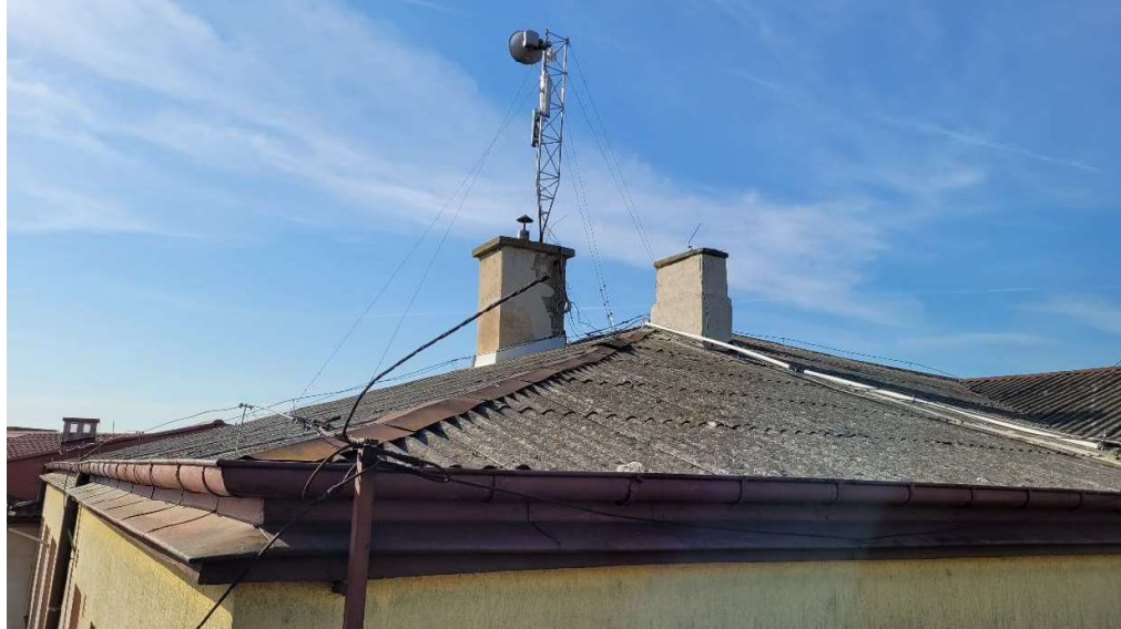
Fot. 1 – Widok na wschodnią część dachu szkoły, komin spalinowy z masztem antenowym, okap z rynnami i rurami spustowymi, gzyms ściany zewnętrznej, fragment instalacji odgromowej do demontażu
