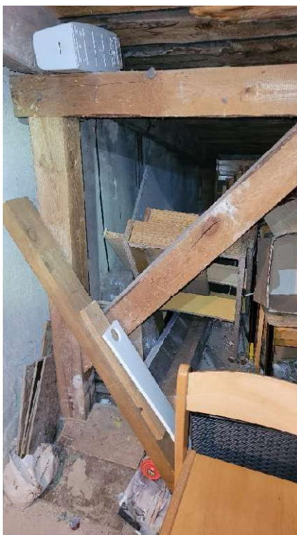
Fot. 11 – Widok na ściankę stolcową poddasza łącznika
