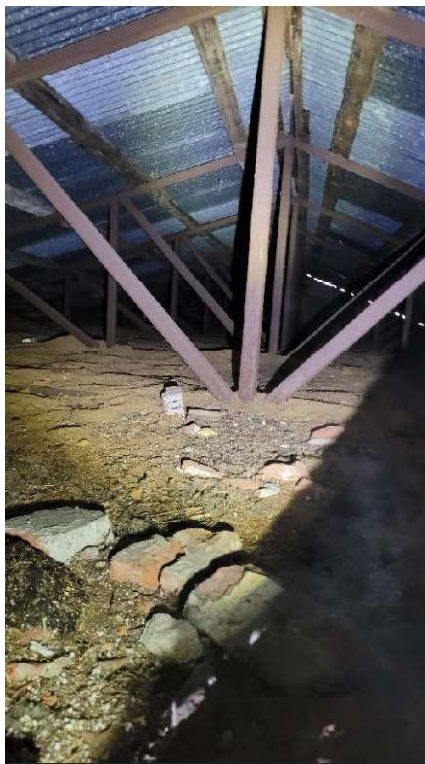
Fot. 15 – Widok na konstrukcję dachu dawnej sali gimnastycznej – dźwigary stalowe – kratowe
