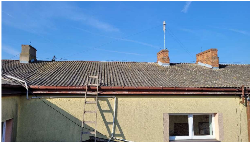
Fot. 2 – Widok na wschodnią część dachu szkoły, kominy wentylacyjne z masztem antenowym, okap z rynnami i rurami spustowymi, gzyms ściany zewnętrznej, fragment instalacji odgromowej do demontażu
