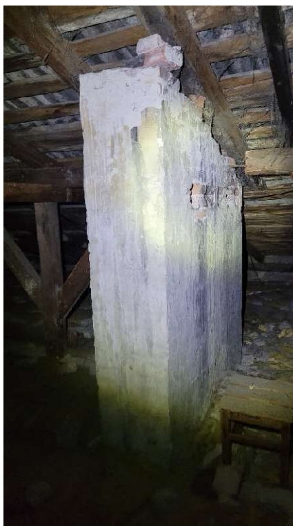
Fot. 5 – Widok na zachodnią połąć dachową i komin nie wyprowadzony nad połąć dachową
