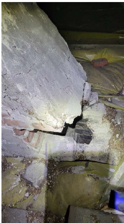
Fot. 6 – Widok na ubytki cegły w kominie
