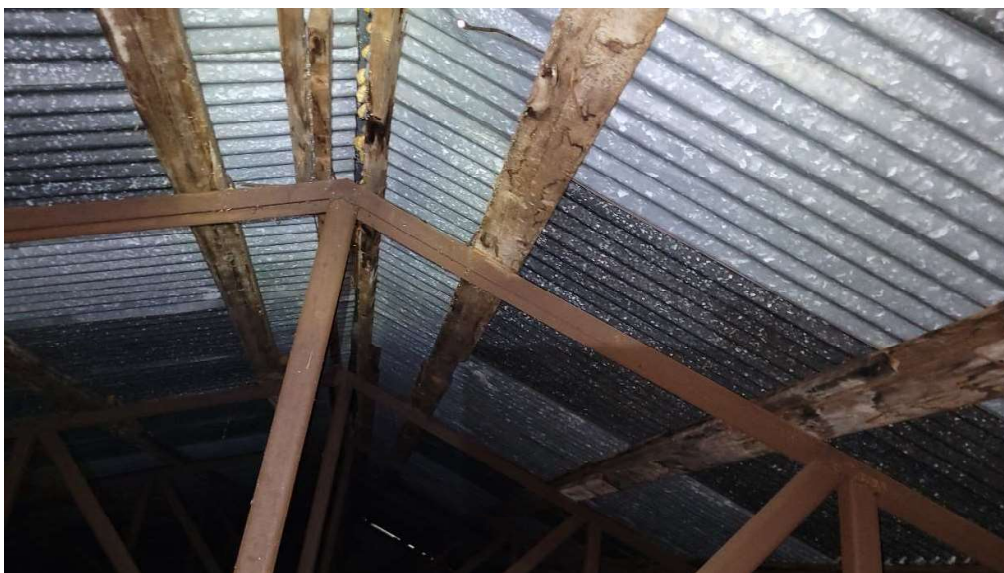
Fot. 17 – Widok na deskowanie ażurowe pod blachę stalową, falistą dachu dawnej sali gimnastycznej
