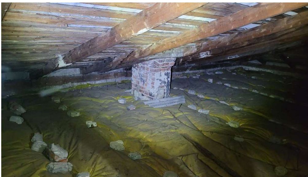
Fot. 4 – Widok na południową połąć dachową i komin nie wyprowadzony nad połąć dachową
