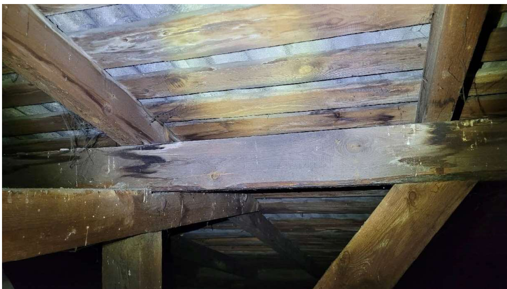
Fot. 3 – Widok wiązar główny więźby płatwiowo – kleszczowej, deskowanie ażurowe
