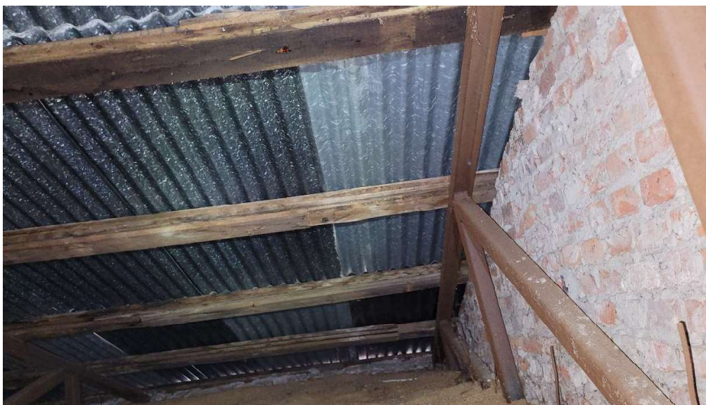
Fot. 18 – Widok dźwigar stalowy i łąty z desek pod pokrycie z blachy falistej
